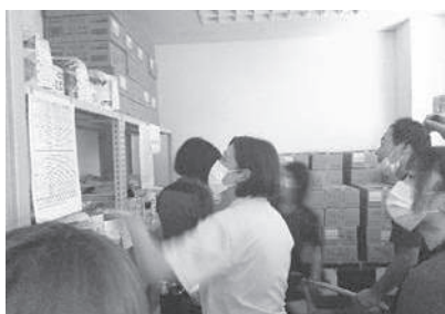
停電の設定のため懐中電灯で照らしながらの作業
